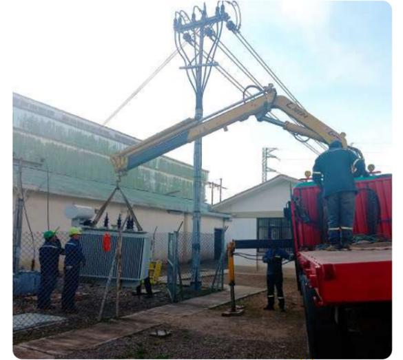
*Mantenimiento general de transformador zig-zag de barra 10.5 KV S/E Aranjuez.*
