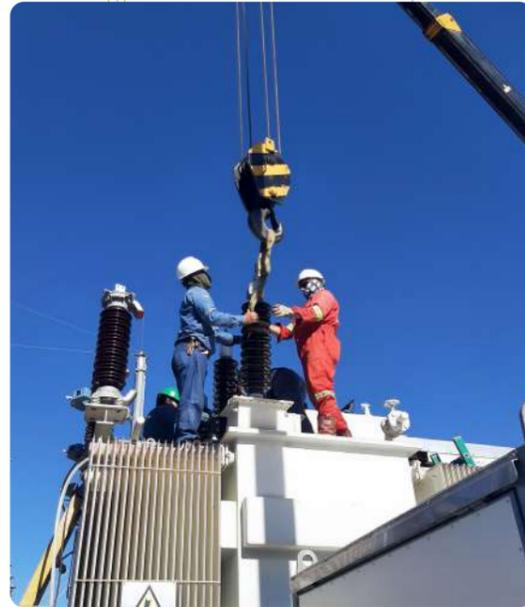
También durante la gestión 2023 se realizaron otros mantenimientos preventivos en la parte eléctrica como ser mantenimiento general al reactor de la barra de 10.5 KV de Subestación Aranjuez y los ensayos regulares en transformadores TARJ06901 (T4) y TRARJ06902(T5).
